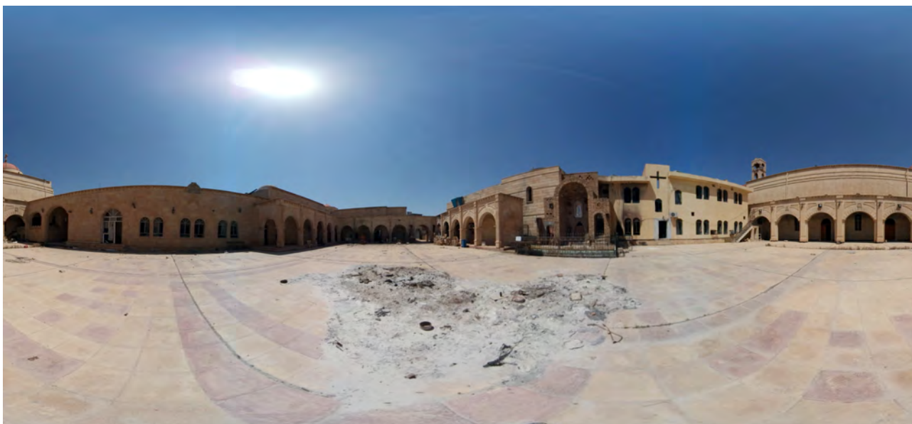
Figura 46: Cortile della Chiesa di Santa Maria Immacolata
