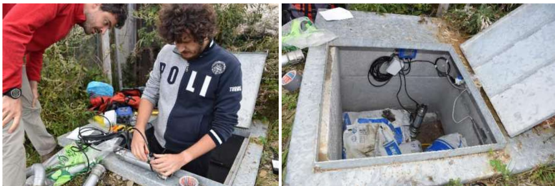
Fig. 19. Installazione di un misuratore di portata a ultrasuoni in un pozzetto di alimentazione per i cannoni da neve.
