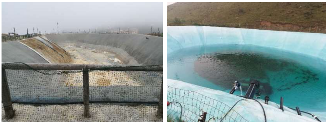
Fig. 7. Laghetti per l'innevamento tecnico a Prato Nevoso, con volumi rispettivi di 27mila mc (a sx) e 11mila mc (a dx).
