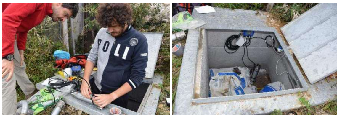
Figure 19. Installation d'un débitmètre à ultrasons dans le puits d'alimentation des canons à neige.
