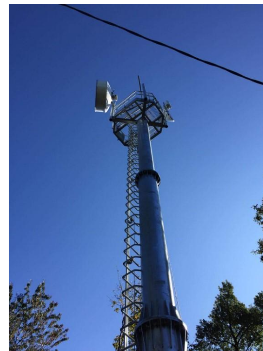
INSTALLAZIONE DI PALO RIPETITORE CHE PERMETTE IL TRASPORTO DELLA BANDA LARGA DA CUNEO A ROBILANTE (CN)
