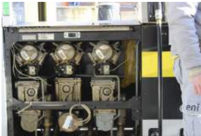
Les moteurs d'un distributeur d'essence de la station-service ENI de Morgex. Ils servent pour pomper le carburant dans le pistolet et après dans la voiture. Morgex, Vallée d'Aoste, Italie 20.02.2020
