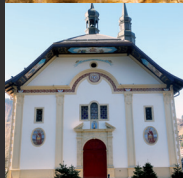
La facciata della Chiesa di Saint-Gervais restaurata nel 2016
