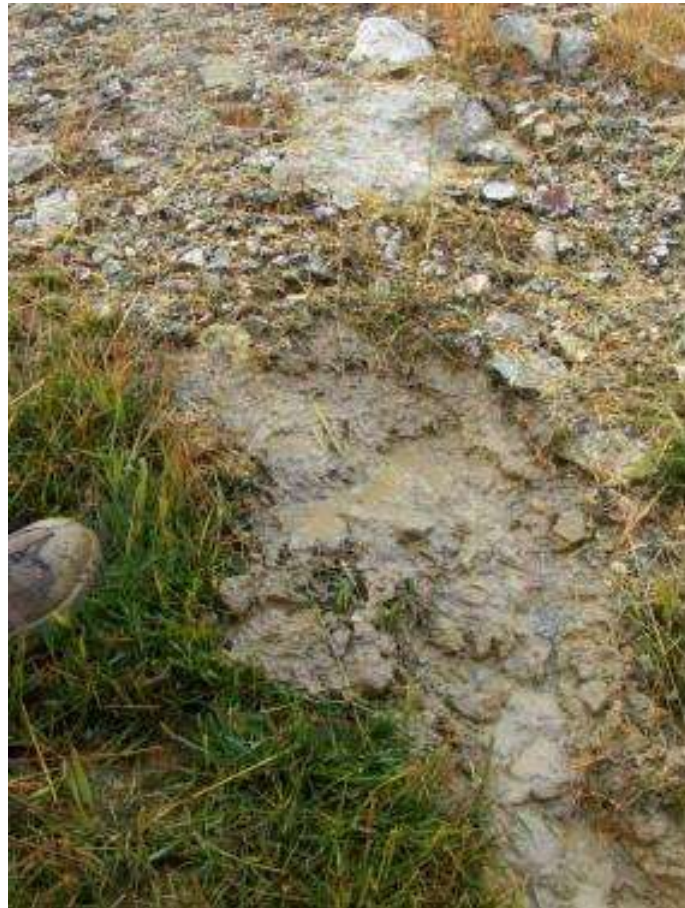
Figure 6 : Fuite (Source : INRAE)
