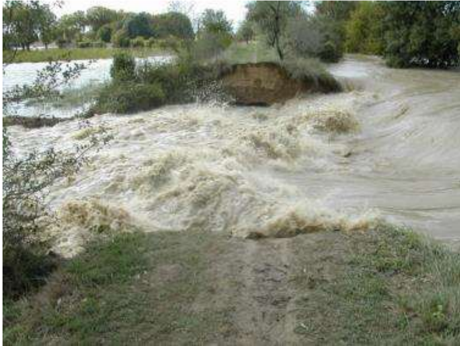
Figure 1 : Brèche initiée par une surverse sur la digue du Vidourle (Source : SIAV)
