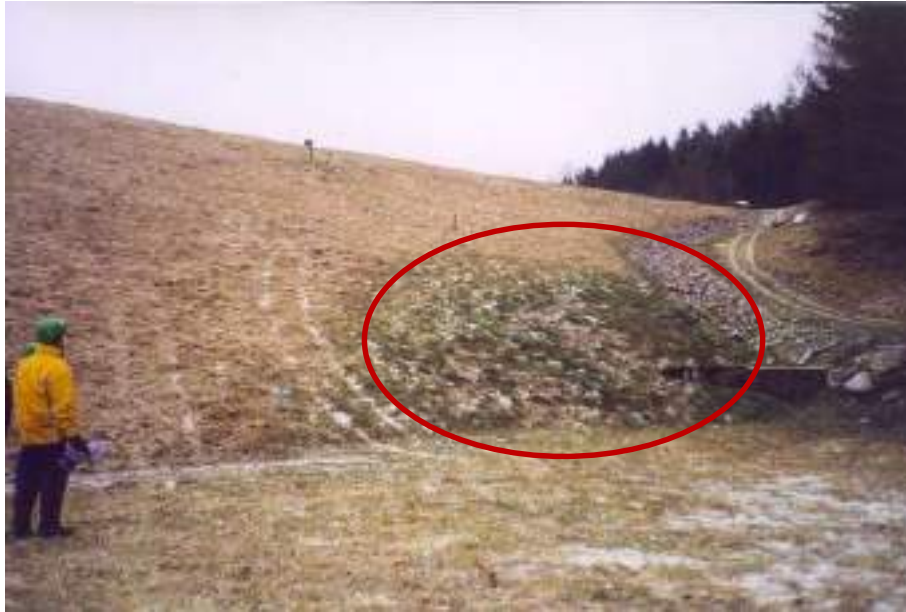
Figure 7 : Zone humide en pied aval (Source : INRAE)
