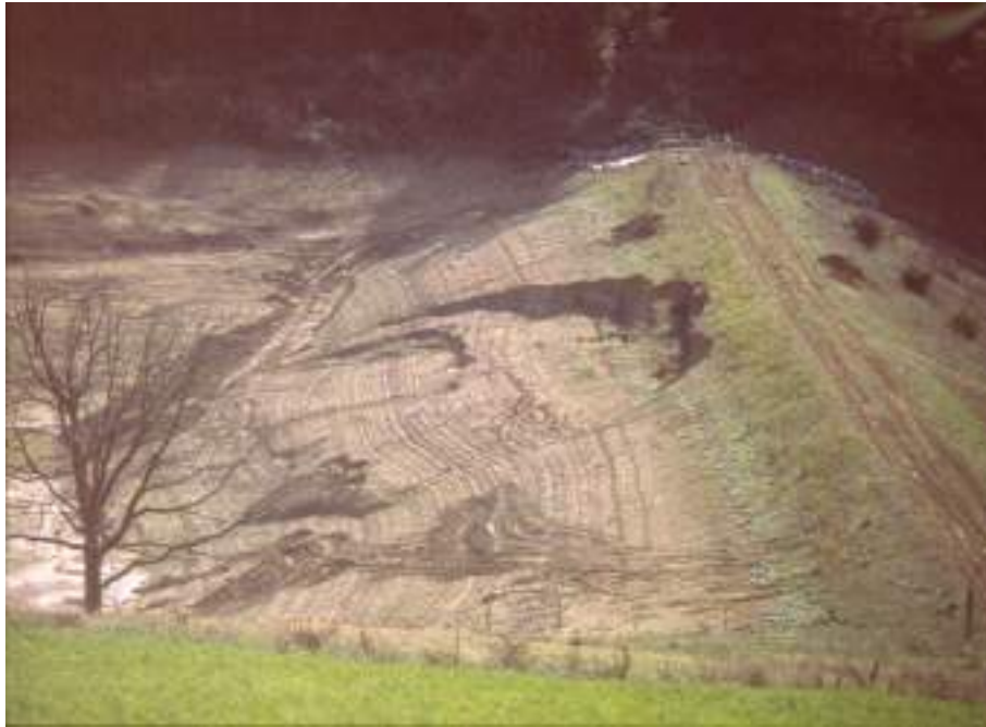
Figure 8 : Glissement de parement amont (Source : INRAE)
