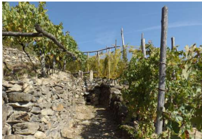
07 Chemin entre murets en pierres sèches. Levone (TO) | Passaggio tra muretti in pietra a secco. Levone (TO).
