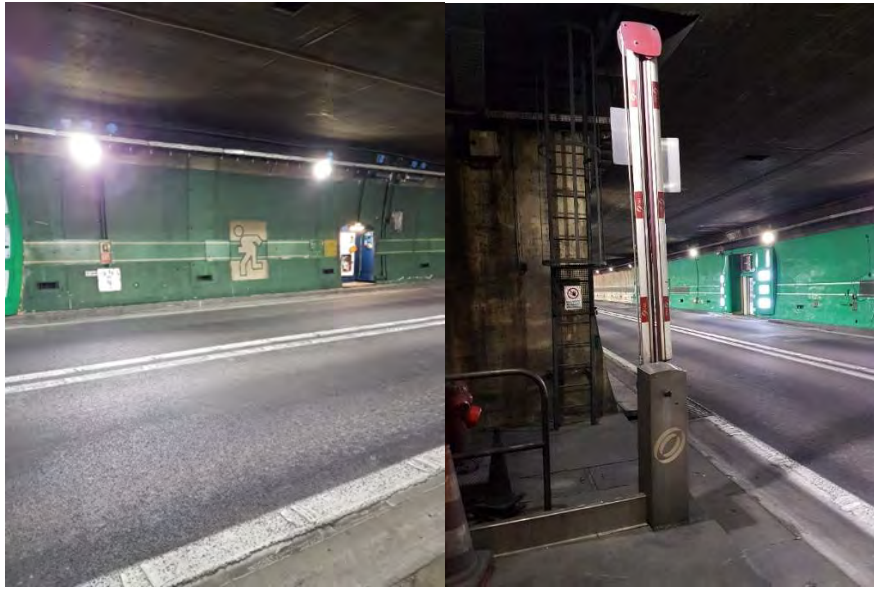
Figure 71: Photos prises dans le tunnel
