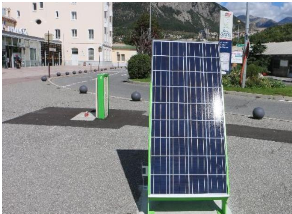
Exemple de panneau pour l'alimentation des bornes de recharge à la gare de Briançon (Photo source : Citec)
