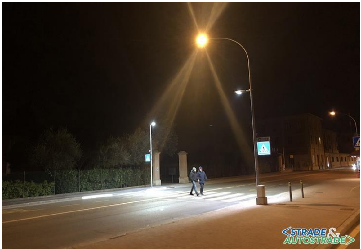
Exemple de passage piéton éclairé (Source : article dans la revue technique Strade&Autostrade)
