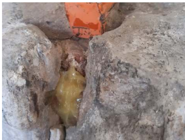
21 - 22: La Lastra di pietra del Roja durante le fasi di incollaggio
