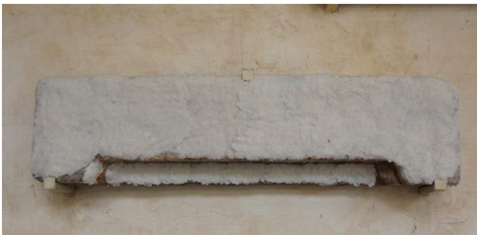
10 -11: Architrave in marmo con un'iscrizione in eleganti caratteri gotici) Prima dell'intervento e durante l'impacco di pulitura
