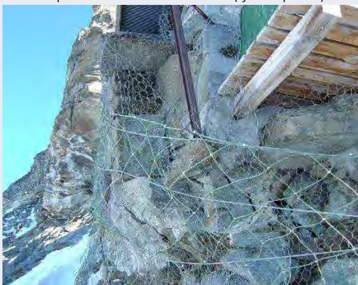
Figure 7.6. Installation de filets et rénovation des fondations du refuge Carrel (3835 m, Italie ; Vuilleumier, 2014).
