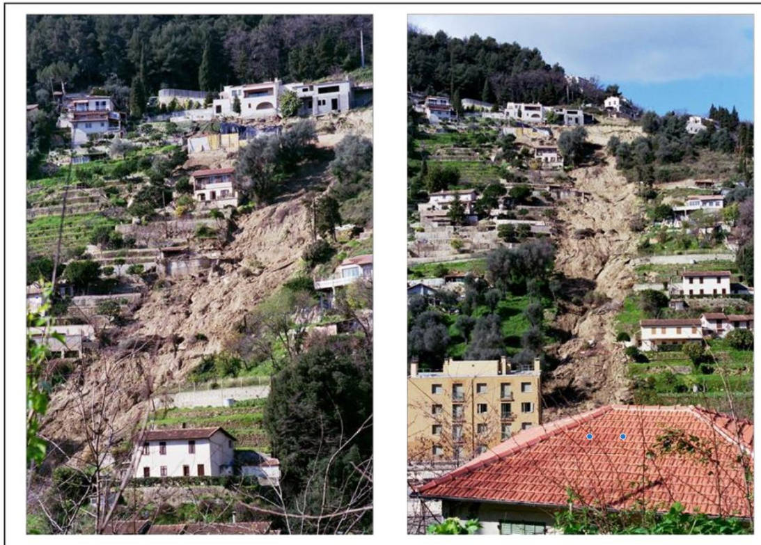
Figure 11 : Illustration des glissements de terrain superficiels sur Menton suite aux épisodes pluvieux en 2000 © BRGM
