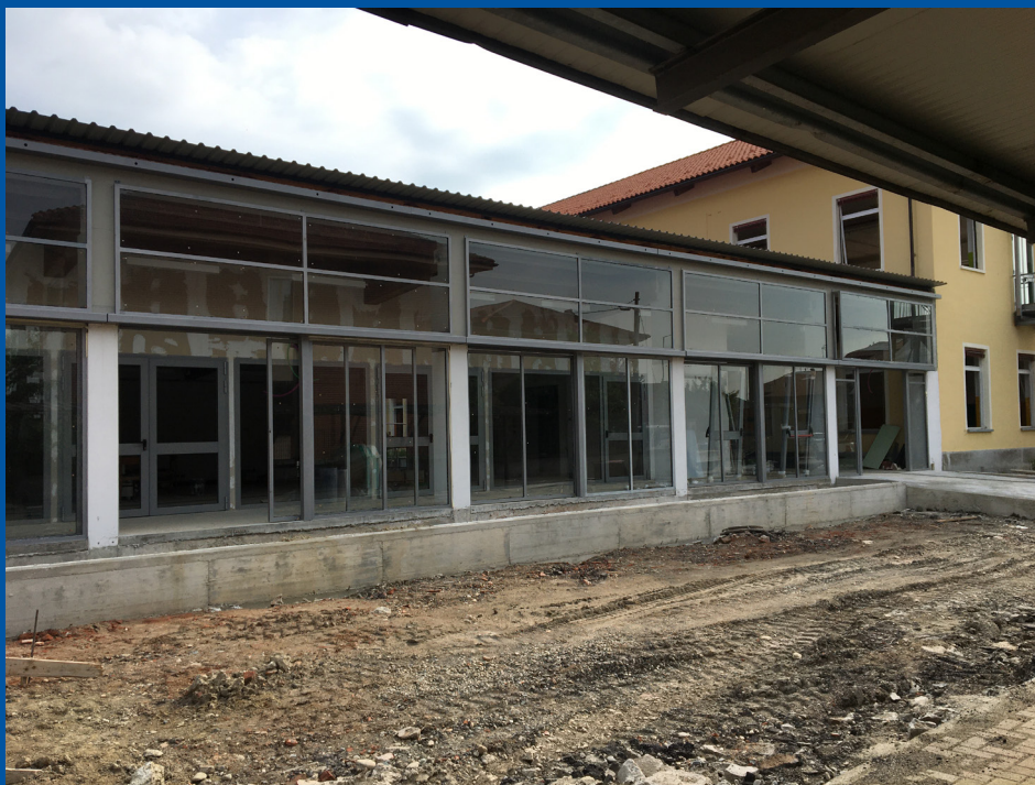
Cantiere mensa di Vigone
